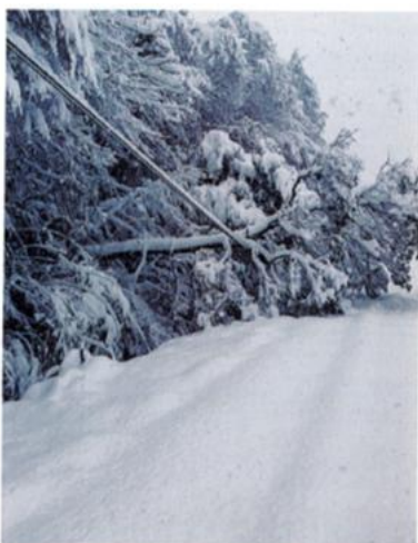
1/22 天橋立・岩滝口間
